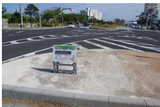
図-1 土系舗装の試験施工
